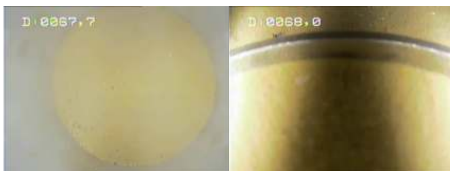
Figure 14 : Pot de décantation et fond de l'ouvrage à - 68 m
